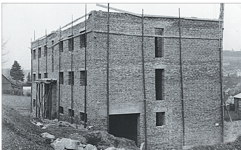
Stavba kancelářů Jednoty v dubnu 1959. Foto archiv Muzeum Velké Meziříčí.
