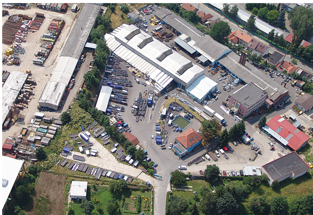
Celkový pohled na původní areál na Karlově před zhruba třinácti lety. Ten firma převzala od Agrostroje Pelhřimov.
