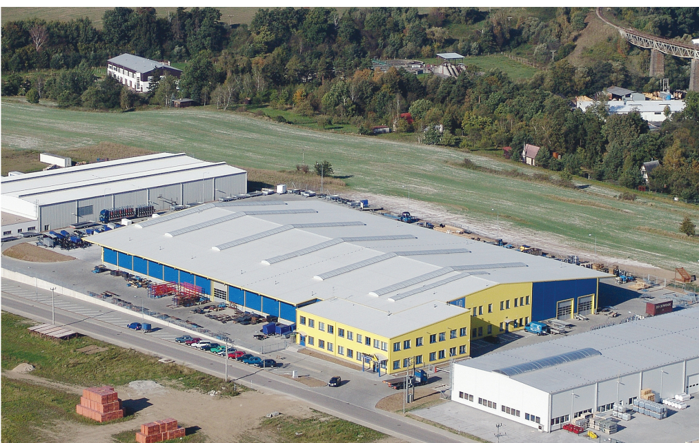
Do nového areálu v průmyslové zóně Jidášky se firma Agados přestěhovala v roce 2006. Postupně byly přistavěny další nové haly.
