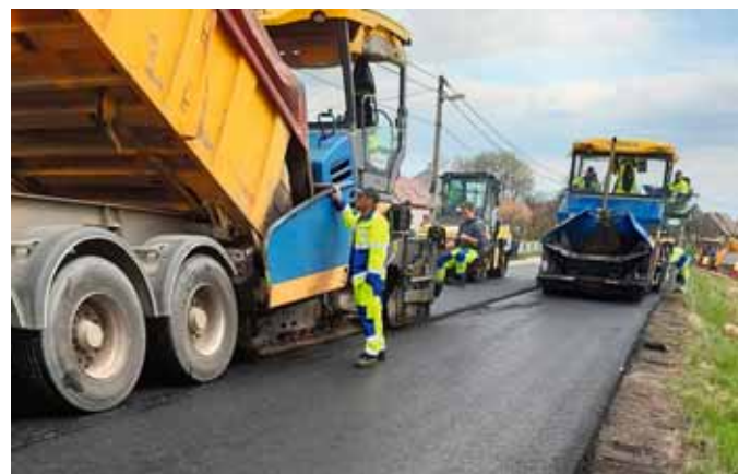
Průjezd obcí Jívoví u Křižanova je uzavřen kvůli opravě komunikace. Ta pomalu spěje k závěru.
