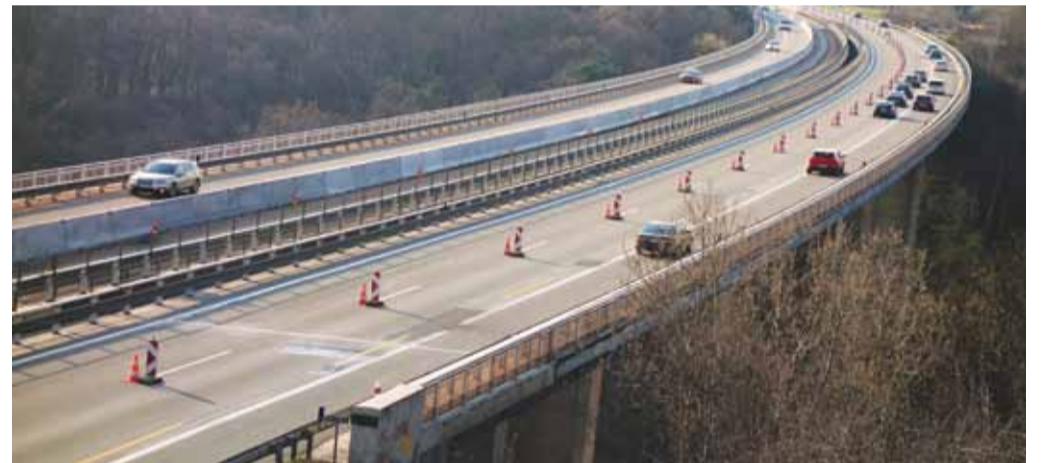
Minulý víkend začalo Ředitelství silnic a dálnic s opravou úseku D1 č. 19 u Velkého Meziříčí. Provoz byl již, jak ukazuje foto, omezen. Foto: Ant. Dvořák
