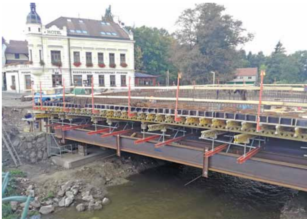
Snímek z minulého týdne zachycuje pokračující práce na výstavbě nového mostu přes řeku Balinku u Jelínkovy vily. Původní obloukový most byl zdemolován na jaře 2018. Podle informací z radnice je dodržován harmonogram a otevření by se tedy nemělo protahovat. Přes nový most, který bude širší než ten původní, by řidiči mohli začít jezdit ještě letos, zhruba od listopadu. Uzavřený úsek se musí i nadále objíždět, přičemž do restaurace Jelínkova vila se hosté dostanou i od centra, a to přes lávky pro pěší. Parkovat mohou na parkovišti vpravo i vlevo, kde jsou vyhrazena stání pro návštěvníky Jelínkovy vily i Bílého koníčka. Text a foto: Iva Horká
