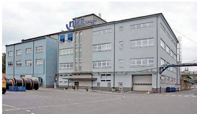
Budova bývalé gumárny, dnes administrativní budova nkt cables.
